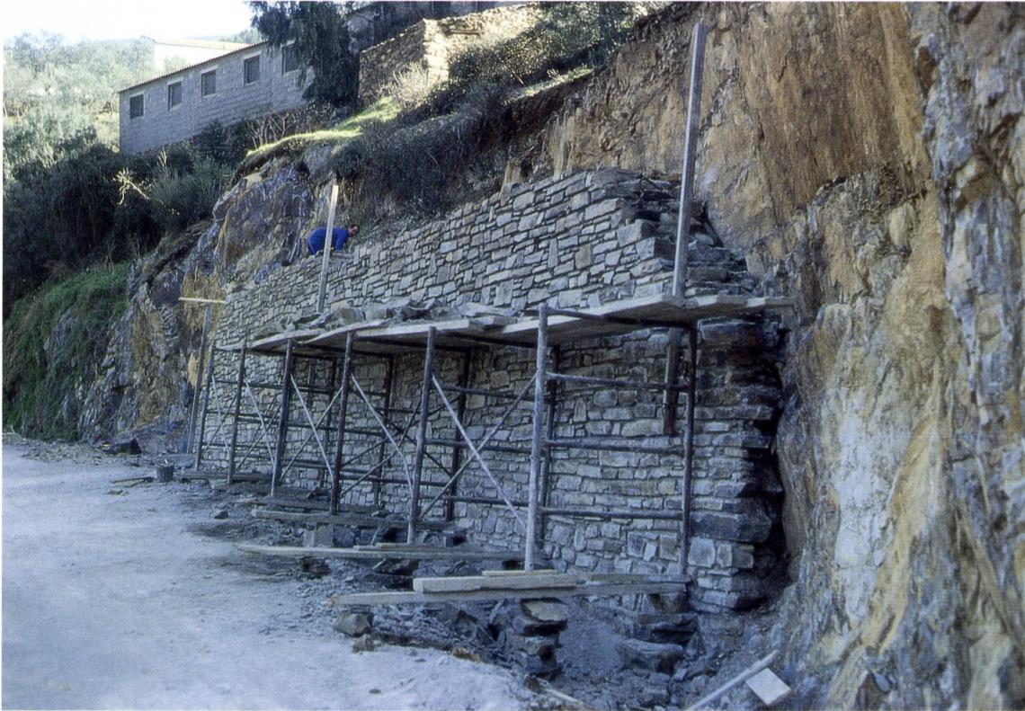
*Los muros de mampostería resuelven infinidad de problemas (erosión, deslizamientos, estéticos, drenaje...) y generan mano de obra local.*
