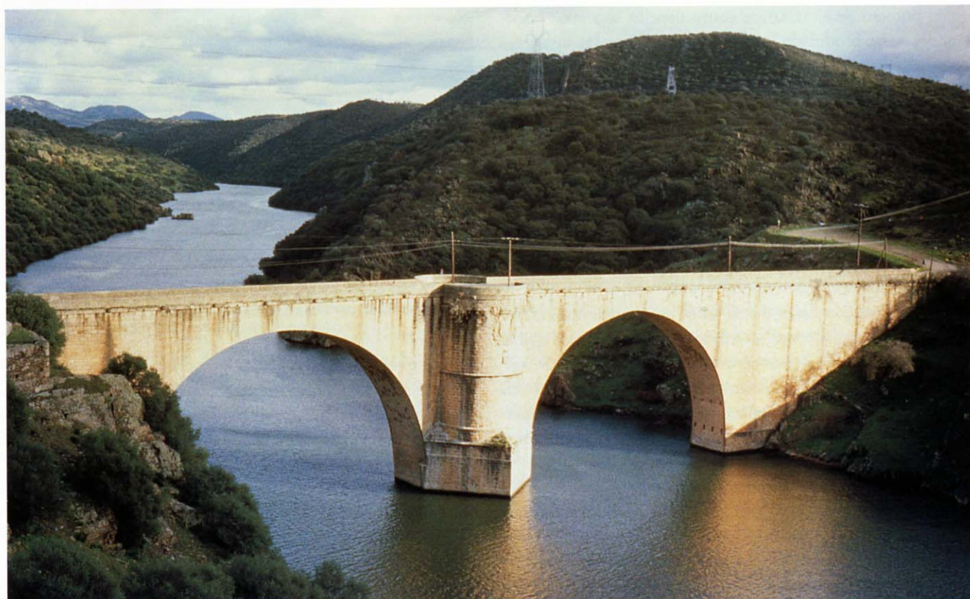
Fig. 6. El maravilloso puente de Almaraz, sobre el río Tago, llora mudo la pérdida de su río, del canto de las agrestes aguas y de la caricia de sus arenosas playas; pues bien sabe que un embalse nunca puede parecerse a un río.
